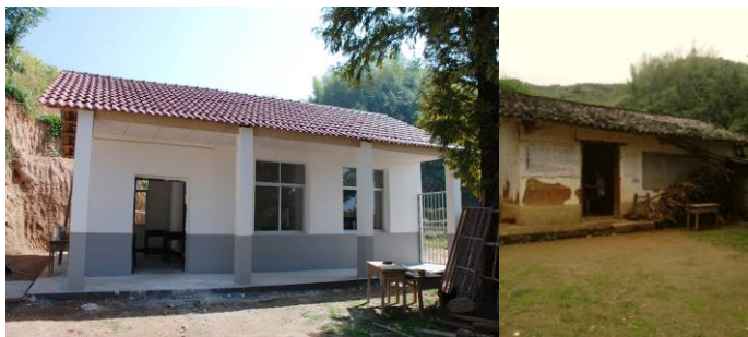
图 3 学校新建的厨房 图 4 学校原先破败的旧厨房
