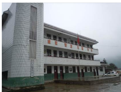
图 2 黄连小学教学综合楼
