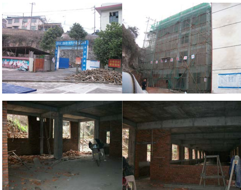
图 3 在建教学楼（1 楼整层将是新厨房和餐厅等厨房配套用房）
