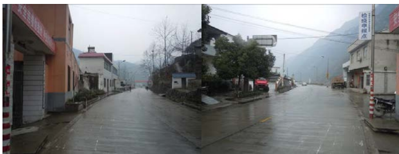
图 1 过渡湾村完小周边道路情况
