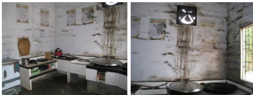
图6 厨房墙面、地面及砧板组图
