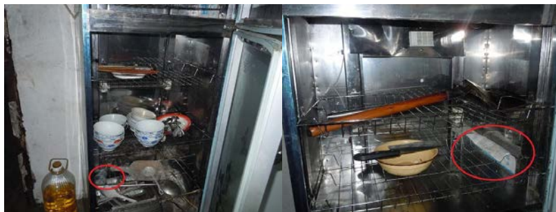
图7 未通电工作的消毒柜（图中红圈处为塑料杯子和废纸）
