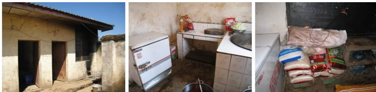
图 3 厨房及储藏室组图
